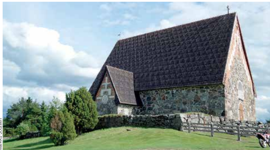
Tuholpolton jälkeen uudelleen rakennetun Tyrvään Pyhän Olavin kirkon paanukattoon tarvittiin 4 000 litraa hautatervaa.
